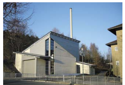
Die neue Heizzentrale in Eslohe liefert so viel Wärme, dass es für ein Schulzentrum, Kurhaus, Seniorenheim und Hallenbad reicht
